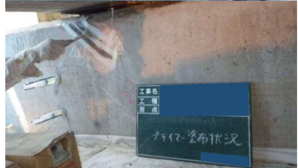
▲躯体補修（ひび割れ注入工法）
