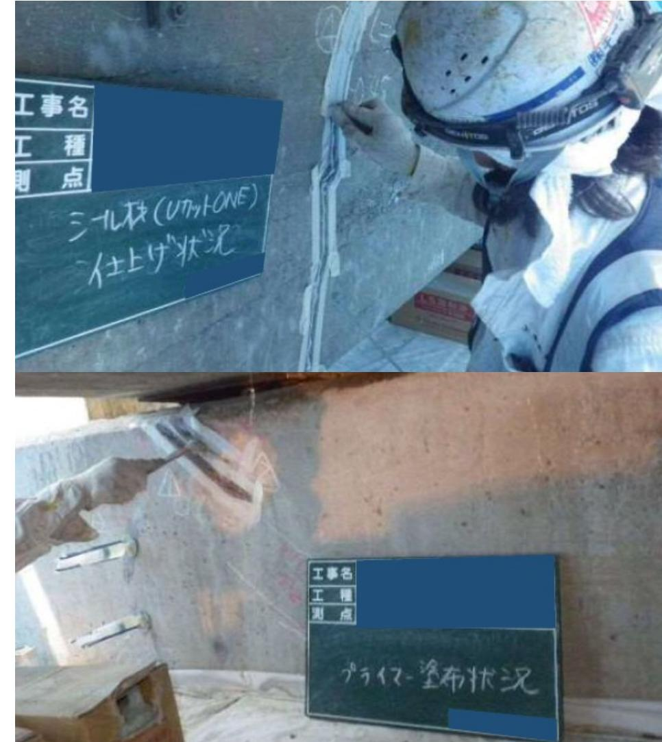
▲躯体補修（ひび割れ注入工法）
